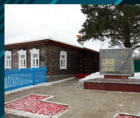
Дом В.Кулик в д. Петрищево, где Зоя провела последнюю ночь перед казнью. Отреставрирован РВИО в 2016 г.
